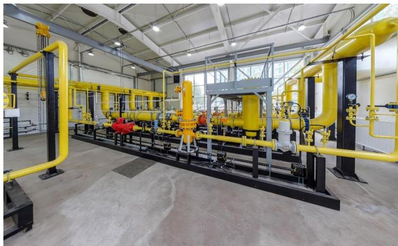
**ГАЗОРЕГУЛЯТОРНЫЕ УСТАНОВКИ НА РАМЕ**
